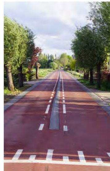
Dijk als fietsstraat
