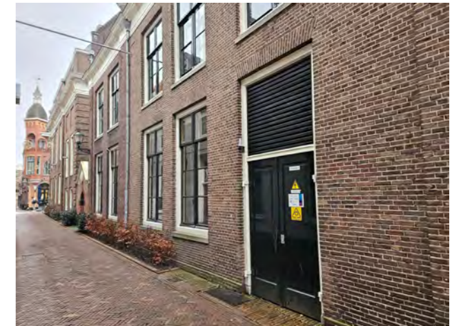
Subtiel inpandige trafo huisjes bij het stadhuis van Alkmaar
