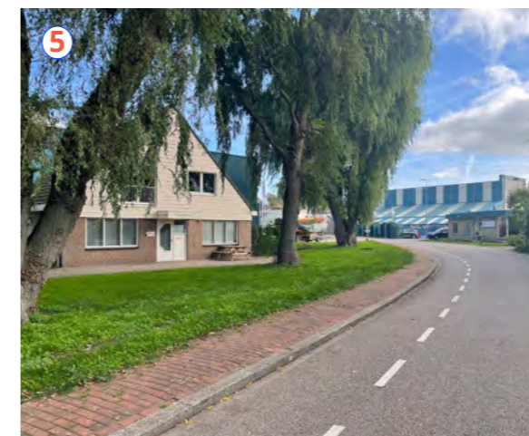
Huidige situatie Omringdijk
